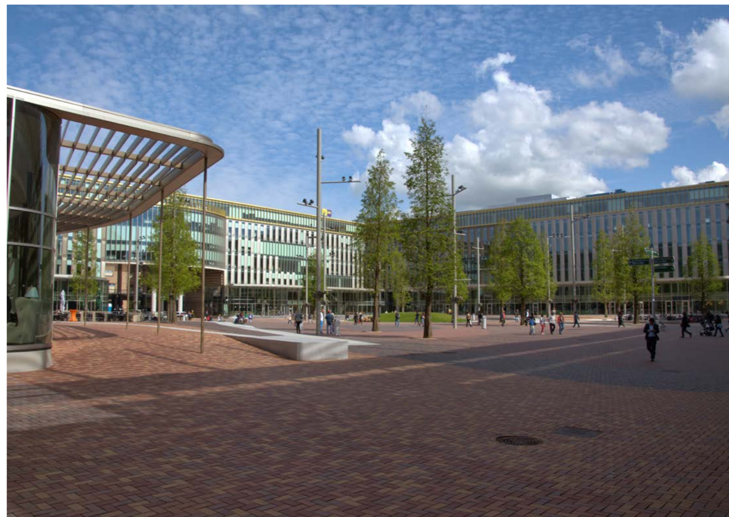
► Nuon: die zentrale Lage, fast sogar im Bahnhof Bijlmer Arena, ist höchst attraktiv und durch perfekte ÖPNV-Anbindung eine Reduzierung des mobilitätsinduzierten Carbon footprint . © Wim Kooij
