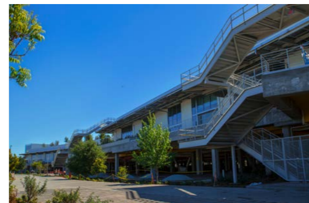
► Das Dach mit Bewuchs absorbiert die Hitze – und unterstreicht Frank O. Gehrys Statement. © Facebook
