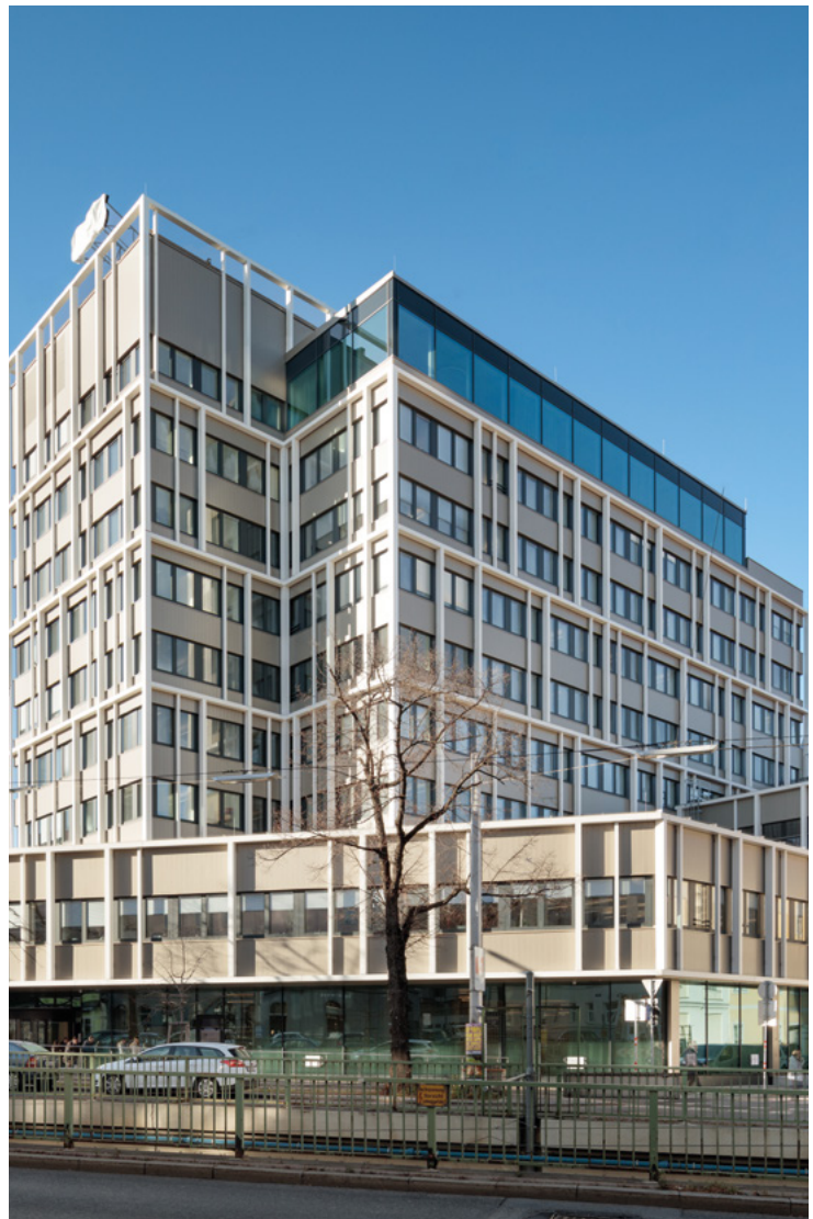
Abb. 17 – Sozialversicherungsanstalt der Selbständigen, Sanierung, Wien (Quelle: ATP architekten ingenieure)
